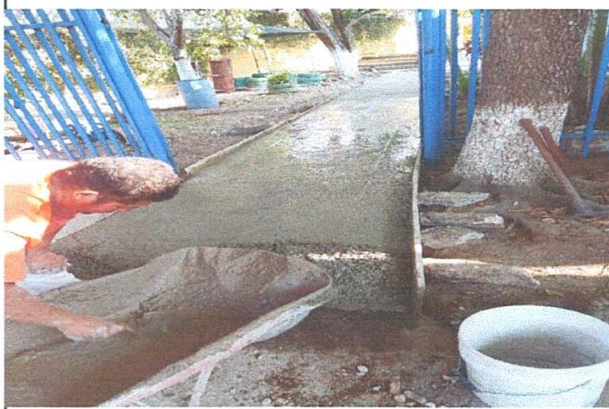
Foto 1: Losa de patio
