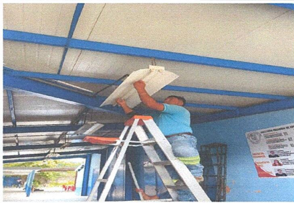
Foto 3: Reparación sistema eléctrico
