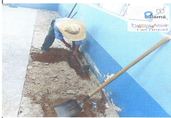
Foto 2: Reparación de pisos
