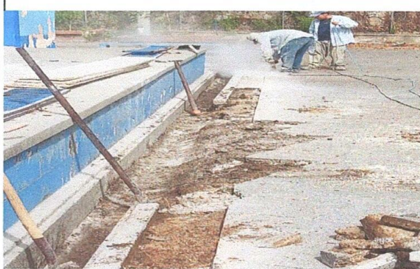
Foto 3: Cuneta de concreto
