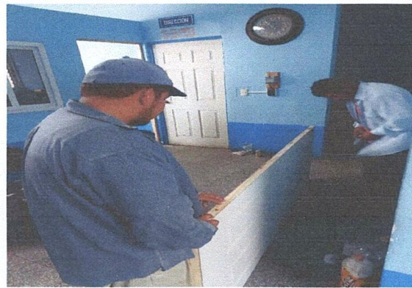
Foto1: Instalación puerta y ventana
