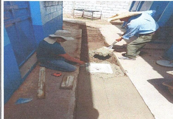
Foto 2: Cuneta para desagüe de aguas pluviales
