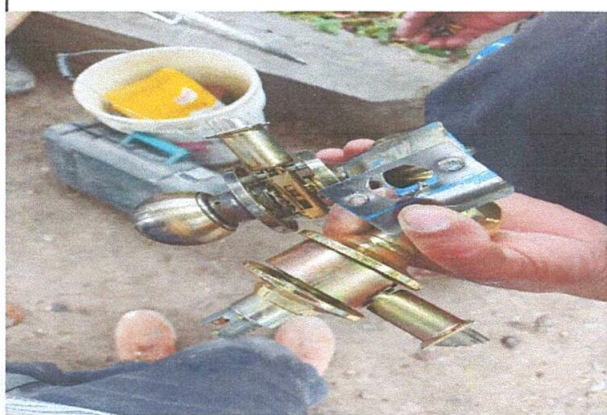
Foto 1: Cambio de chapas
